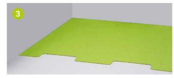
3. Zuschnitte werden mit einem Teppichmesser ausgeführt. Zu Wänden und Durchführungen ist ein Randabstand von 10 mm einzuhalten. Bei der "Puzzle"-Variante wird hierbei empfohlen, eine gerade Kante als Abschluss zu den Wänden zuzuschneiden.
