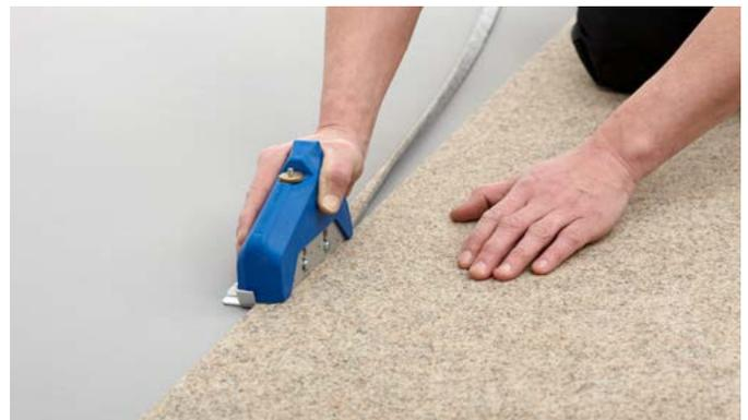
Die zweite Bahn wird im Nahtbereich ca. 2 cm überlappend ausgerollt und nach der Verklebung dicht an die untenliegende Bahn geschnitten. Hier kann ein Linocut mit höherer Anschlagkante verwendet werden.
