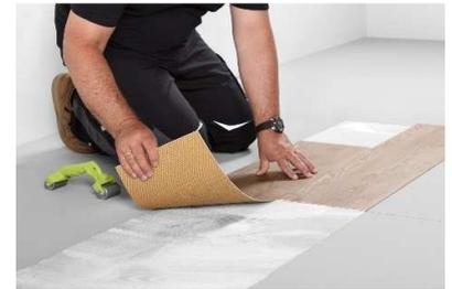
Die Planken werden innerhalb der angegebenen Einlegezeit ins nasse Klebstoffbett eingelegt. Es ist darauf zu achten, dass nur so viel Klebstoff aufgetragen wird, dass die Einlegezeit nicht überschritten wird. Die Verarbeitungsempfehlungen der Klebstoffhersteller sind einzuhalten.
