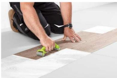
Der Belag sollte gut angerieben und im Anschluß mit einer ca. 70 kg schweren, mehrgliedrigen Walze angewalzt werden.
