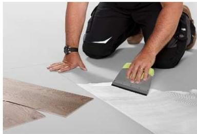
Entlang des maßgebenden Schnurschlages wird Klebstoff (646 Eurocol) oder gleichwertig, unter Verwendung einer Zahnleiste TKB A3 aufgetragen.
