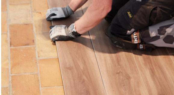
Zum Einfügen der letzten Plankenreihe müssen die Planken in der Regel zugeschnitten werden. Legen Sie dazu eine Planke deckungsgleich auf die vorletzte Reihe, legen Sie eine weitere Planke obenauf und positionieren Sie diese mit der Außenseite direkt zur Wand. Zeichnen Sie ihre Vorderkante auf der Diele darunter ein. Berücksichtigen Sie dabei den einzuhaltenden Randabstand. Jetzt können Sie diese Planke passend zuschneiden und zusammen mit den anderen Planken der letzten Reihe einrasten.
