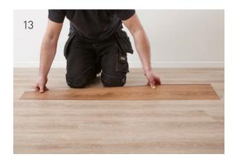
Passen Sie die Diele in die Laschen an der anderen kurzen Seite der Öffnung ein, indem Sie die Diele leicht biegen.
