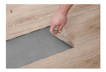
Hebeln Sie den ersten Teil der Diele heraus, indem Sie einen Spachtel im Mittelschnitt der Diele ansetzen. Lösen Sie den ersten Teil der Diele von den angrenzenden Dielen.
