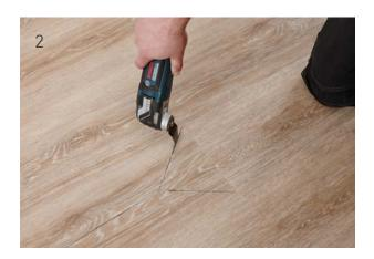
Schneiden Sie ausgehend vom Mittelschnitt vorsichtig schräg zu den vier Ecken der Diele. Achten Sie dabei darauf, dass Sie nicht in die angrenzenden Dielen schneiden oder diese beschädigen.
