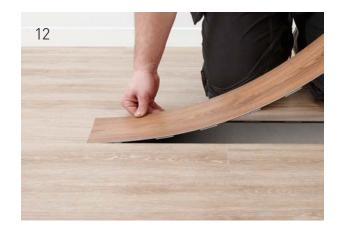
Setzen Sie die Austauschdiele mit der kurzen Seite an, indem Sie die Diele auf die Laschen der bereits verlegten Diele auf dem Boden klicken.
