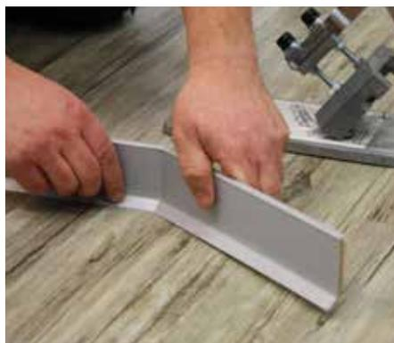
Die Innen- und Außenecken können mit der Döllken-Stanze aus dem Profil gebildet werden. Die Montage erfolgt unsichtbar mit dem Döllken-Heißschmelzkleber.
