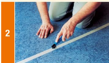
Klebeband mit dem Roll-, Trapez- oder Hakenmesser im Nahtbereich durchtrennen. Bei harten Belägen (z. B. Objektbelägen) ist unmittelbar vor der Verschweißung der Nahtbereich mittels Bügeleisen bzw. Föhn auf max. 40°C zu erwärmen.
