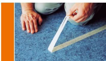
Das Klebeband ca. 10 Minuten nach der Verschweißung schräg nach hinten abziehen.
