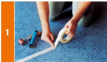
Spezielles Papierklebeband auf die dicht geschnittene Naht mittig aufbringen und mit der Andruckrolle anpressen.
