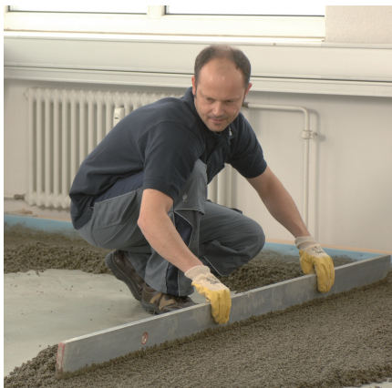
Verlegung des Leichtausgleichsmörtels UZIN SC 914 Turbo
