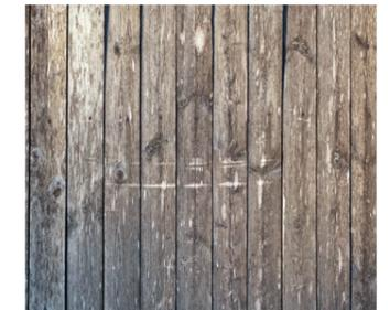
**Den Boden auf Insektenbefall überprüfen.** Sicherstellen, dass der Unterboden eben ist, gegebenenfalls lose Bereiche festschrauben. Unterböden aus Holz müssen grundsätzlich für Luft zugänglich bleiben und sollten über den Randbereich der Fläche belüftet werden. Bei Feuchtigkeit im Holzboden oder im Unterboden aus Holzwerkstoffen, oder wenn unter diesem keine ausreichende Feuchtigkeitssperre vorhanden ist, muss dieser vor der Verlegung des neuen Bodenbelags entfernt werden.
