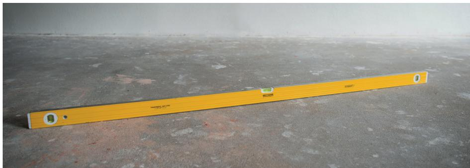
Der Unterboden muss fest, glatt, sauber und trocken, frei von Mängeln und für den Zweck geeignet sein. Nötigenfalls müssen alte Kleber und lose Ausgleichsmasse abgeschliffen und entfernt werden. Stellen Sie sicher, dass der Unterboden eben und frei von chemischen Stoffen und anderen Verunreinigungen ist.
