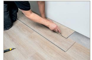
11. Dann verlegen Sie die zweite Diele, indem Sie die Nut in einem Winkel von 25° über die Feder der vorigen Reihe schieben. Positionieren Sie das linke Kopfende der Diele am Ende der vorherigen Diele und schieben Sie es über das Kopfende der vorigen Diele. Drücken Sie nach unten und schieben Sie die Diele mit einem Handroller in die richtige Position. Wiederholen, bis Sie das Ende der Reihe erreichen. Die Endstücke nicht mit dem Hammer einklopfen.
